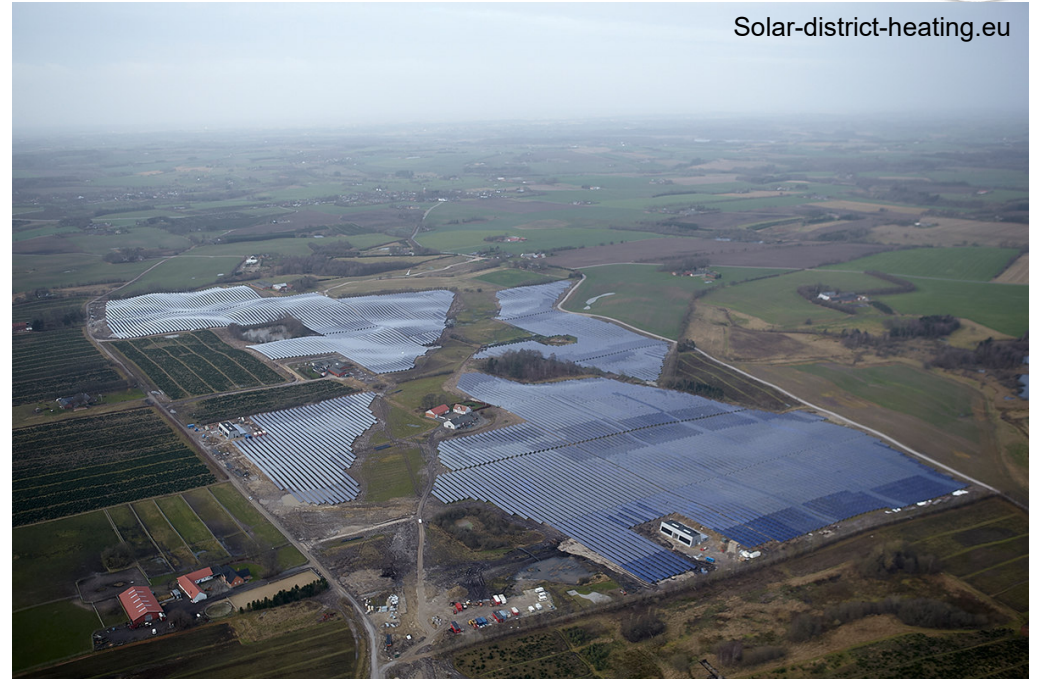
Silkeborg, Dänemark 150.000 m 2 Kollektorfläche Inbetriebnahme Ende 2016 80.000 MWh/a entspricht ca. 20 % des Jahresbedarfs
