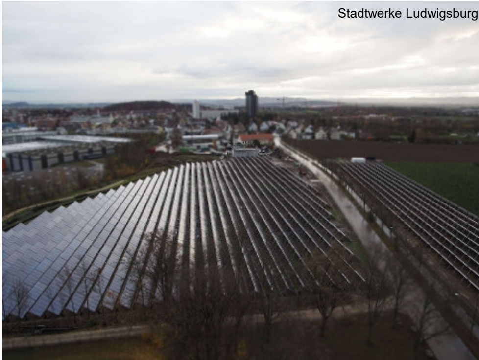
Ludwigsburg, Deutschland 14.800 m 2 Kollektorfläche Inbetriebnahme Spätsommer 2020 5.500 MWh/a bei 9 MW p
